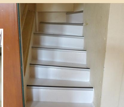
Peinture de l'escalier, du sol du balcon et mise en place des bandes anti-dérapantes.
