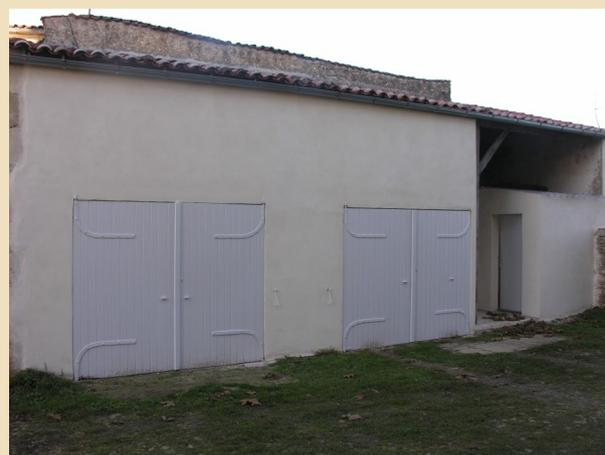
Travaux effectués sur les garages communaux, avant et après. Fermeture et réfection de la façade en enduit taloché et création de toilettes publics.
