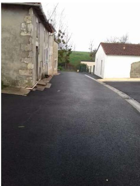
Au village des Michauds, suite au renouvellement des conduites du réseau d'eau potable par le Syndicat des Eaux 17, des travaux d'aménagement de la voirie finition enrobé à chaud avec création d'un réseau d'eaux pluviales pour la rue des Michauds et l'Impasse de la Cigogne ont été réalisés en novembre 2020. pour un coût réel de : 24 352.69 € TTC.
